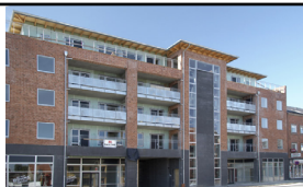
Det nye hus der blev bygget på La Cabana grunden på Silkeborgvej
